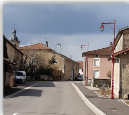
Enfouissement des réseaux à Sandaucourt
