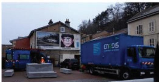
Pose d'un groupe électrogène rue Saint-Michel (Epinal) lors de travaux de maintenance sur le poste HTA/BT
